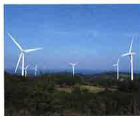
的山(あづち)大島風力発電所
